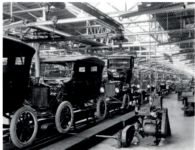
Bild 1 Bereits 1918 führte Ford die Fließbandproduktion ein. Aktuell setzen viele neue Autofabriken im Montageprozess auf flexiblere FTS. Bild: Ford-Werke AG
